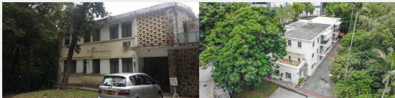
拆卸前的 D 座（右）和 G 座（左） Block D (right) and Block G (left) before demolition
